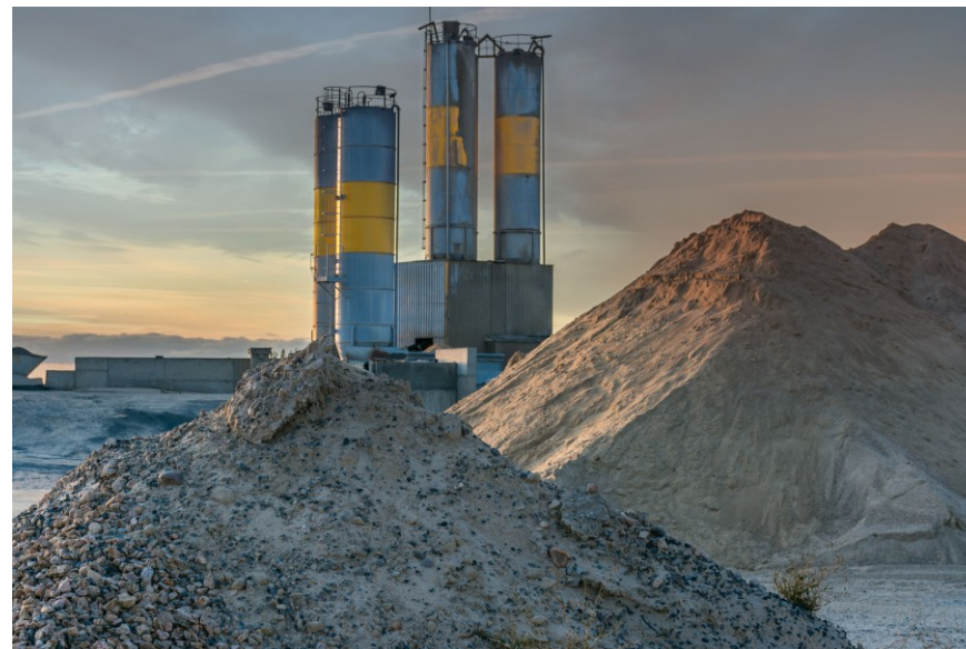
セメント製造の現場
